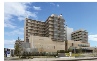
大同病院の外観
