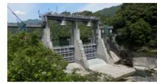
耳川水系で最も古いダム(S4運開) H30.6ダム通砂対策工事完了予定 吊鐘状のクレーンカバーが特徴
