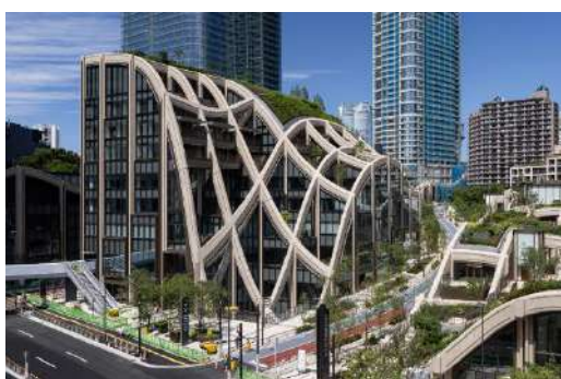
麻布台ヒルズガーデンプラザレジデンス
