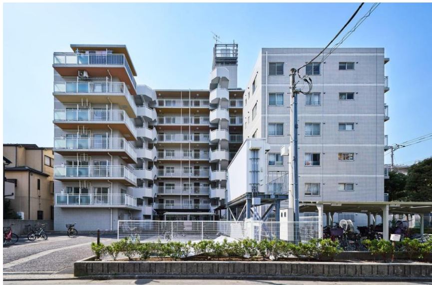
北側外観（撮影：黒岩翼写真事務所）
