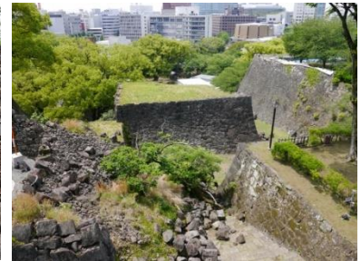
▲いまだ復旧作業が続く石垣の様子
