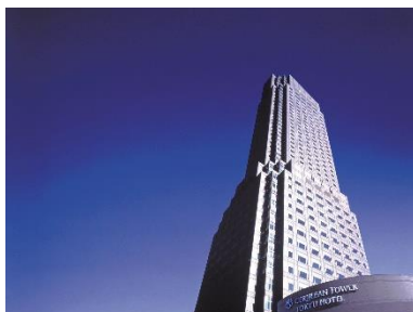
セルリアンタワー東急ホテル
