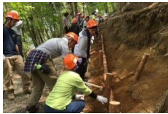
▲従業員による丹波山村でのボランティア活動 (土砂崩れ防止のための木柵づくり)
