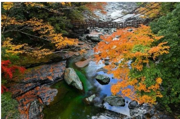
徳島県三好市地方で採取される植物、シラクチカズラで作られ長さ45m幅2mの大きさと水面14mの高さに設置されています。国指定重要文化財であり、昔は深山溪谷地帯の唯一の交通機関でした。3年に一回古くなったカズラを新しいカズラに交換する架替えが行われます。
