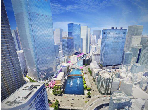
江戸橋上空から首都高速道路の高架橋が撤去された『日本橋リバーウォーク』を望む※
