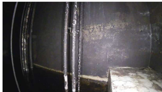
＜中水処理機械室＞
