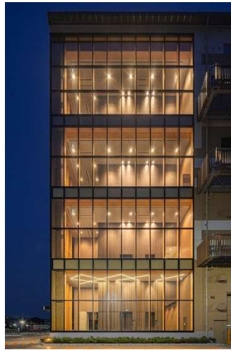
木造共用部 外観
