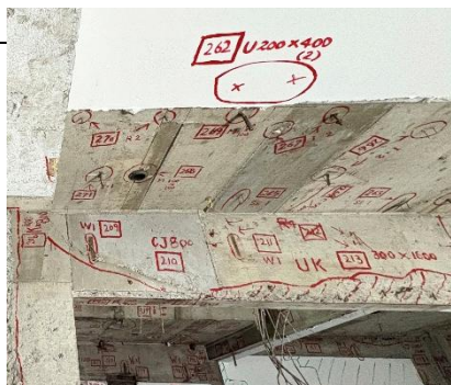
建物の不良箇所の調査
