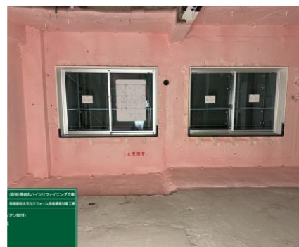
省エネ化のための断熱工事
