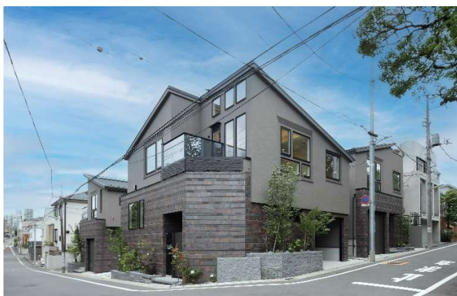
外観竣工写真（2 号棟）
