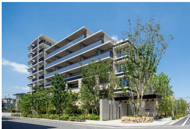
パークホームズ上板橋
