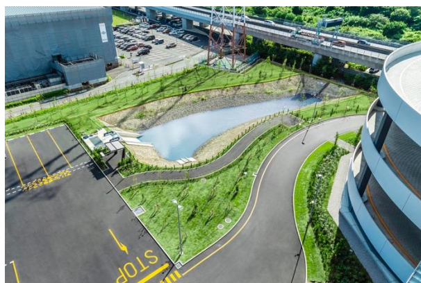
景観に配慮した雨水貯留池
