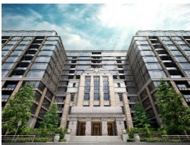
ファサード（南側正面）
