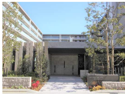
建物エントランス
