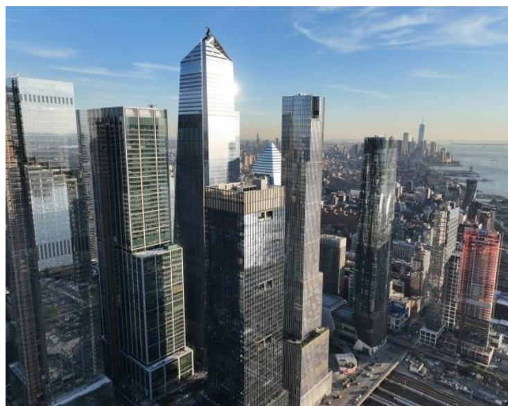
ハドソンヤード全景
