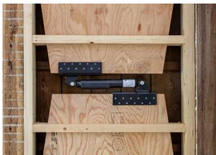
制震オイルダンパー
