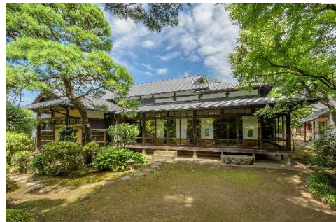
耐震改修工事後
