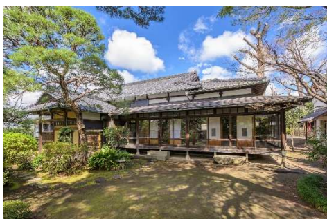
耐震改修工事前
