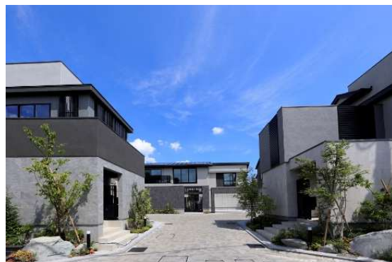
「ファインコート成城ザ グラン」 長期優良住宅認定取得・無電柱化
