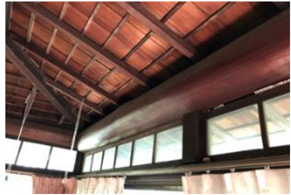
既存住宅内の「大梁」
