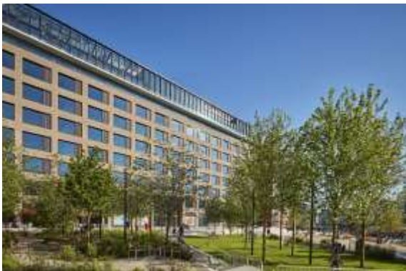
「テレビジョンセンター再開発計画」オフィス棟
