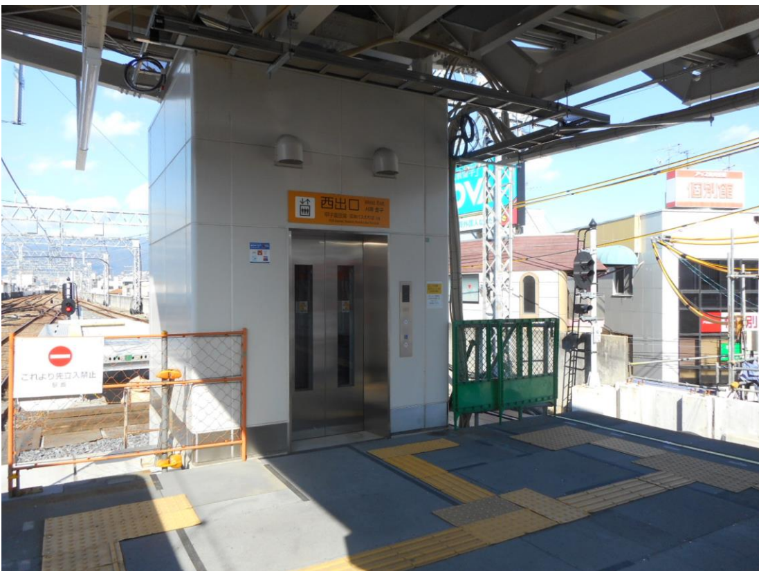
【 西改札側エレベーター (上り線ホーム) 】
