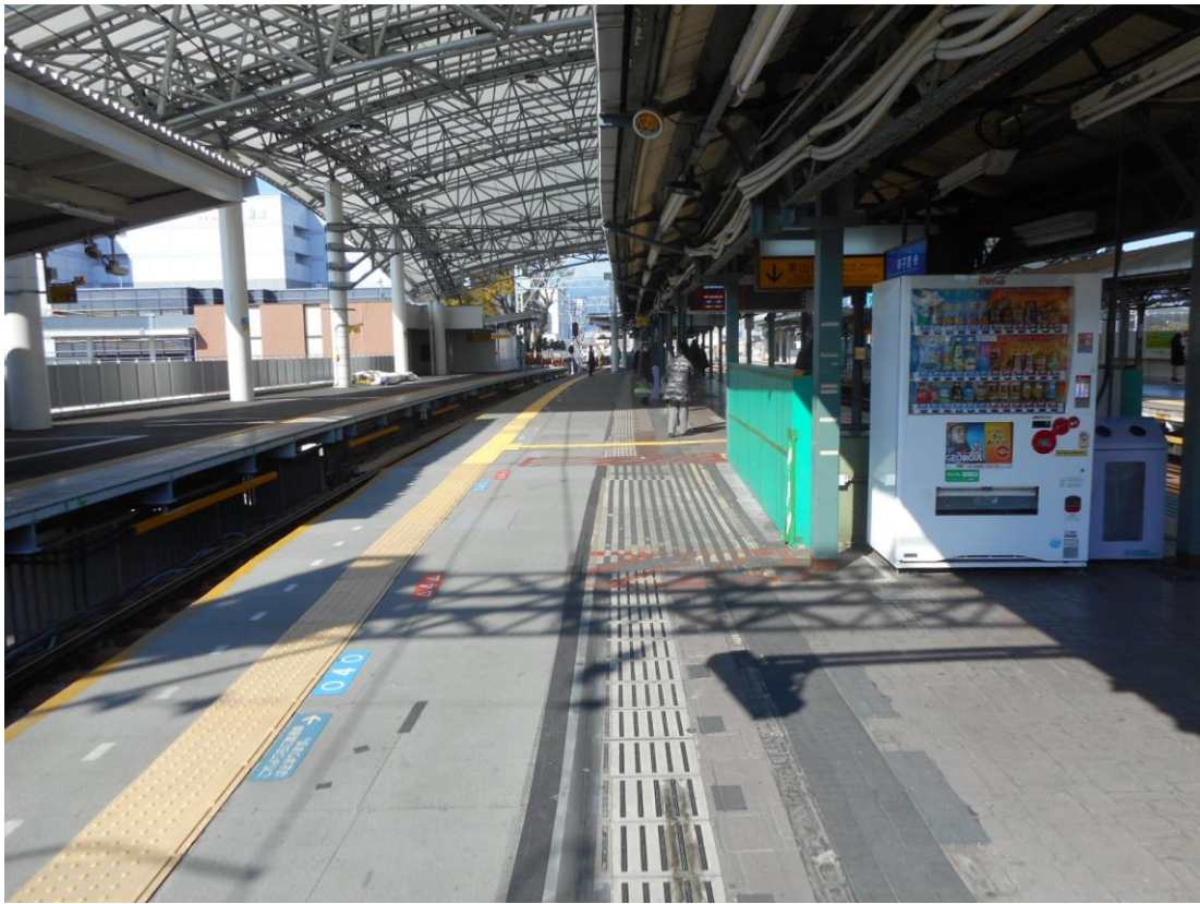
【 ホーム拡幅 （下り線ホーム） 】
