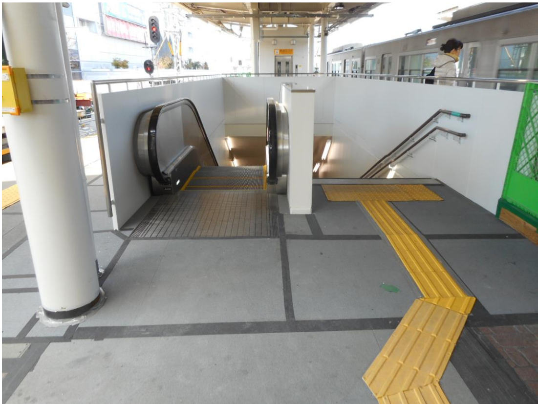
【 西改札側エスカレーター （下り線ホーム） 】
