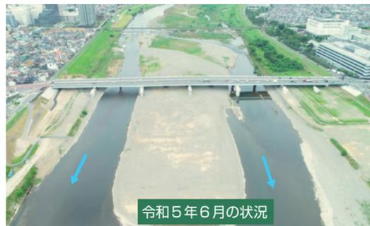
今年の5月には、新しい下流橋を支える橋脚や橋台が全て完成しました。引き続き、橋桁の製作・架設工事に着手しています。完成までに約16年間という大変長い期間を要しますが、今後も、架け替え工事を着実に進めてまいります。
