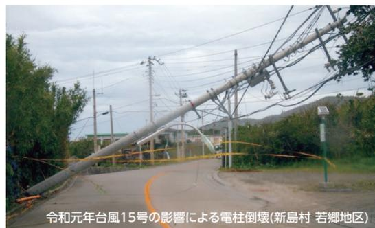
令和元年台風15号の影響による電柱倒壊(新島村 若郷地区)
