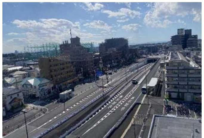
平和台トンネルの全景
