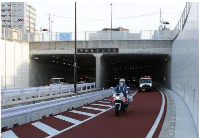
平和台トンネル暫定開通の様子
