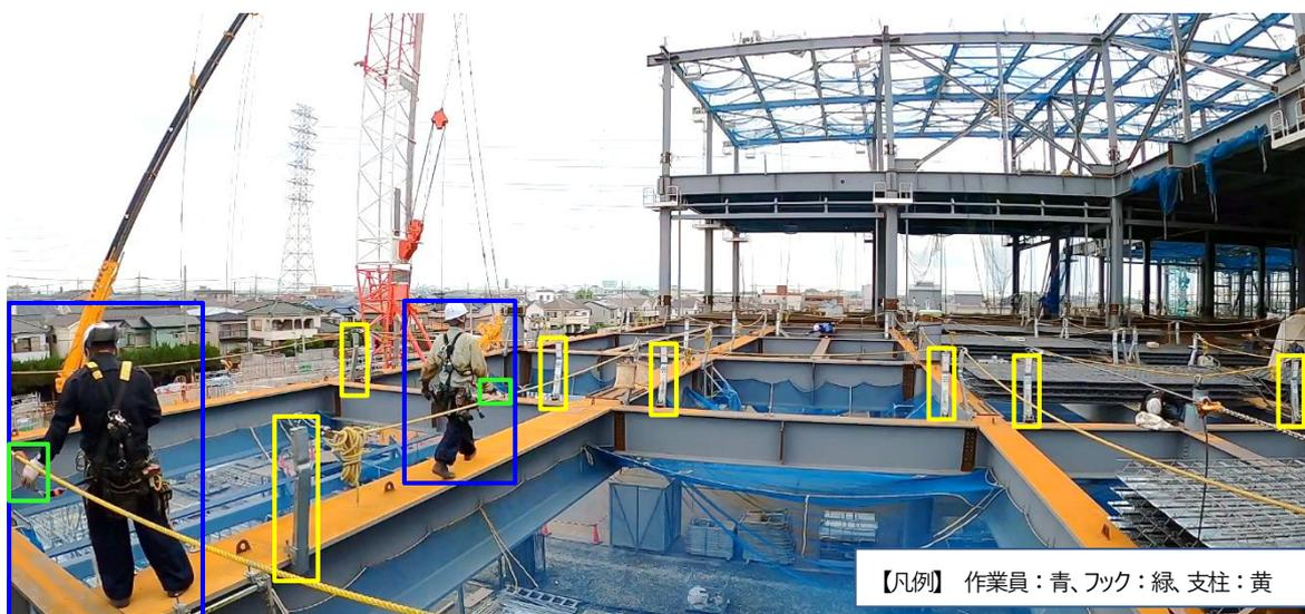
図1 「墜落制止用器具フック不使用者の検知」の検証イメージ
