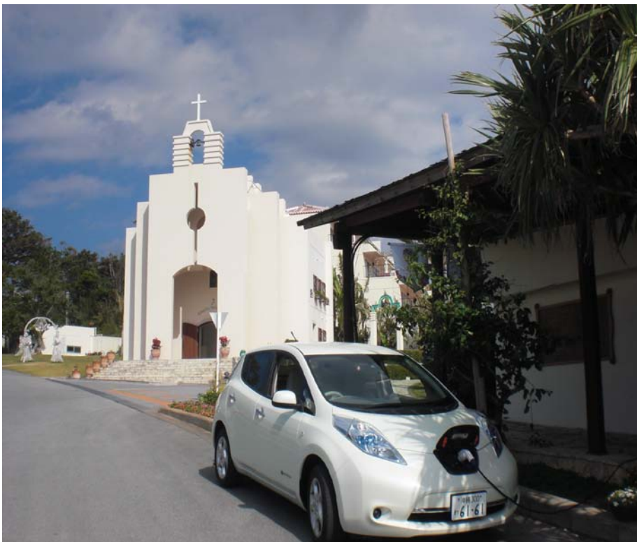
②太陽光発電パネルの電力を日産リーフに充電している様子
