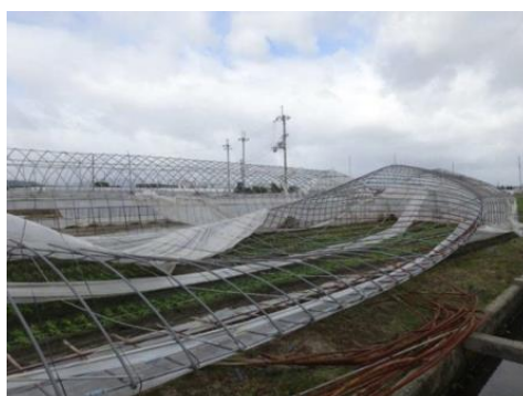
農業への被害も深刻です（城陽市）
