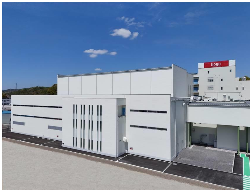
桜が丘工場 外観
