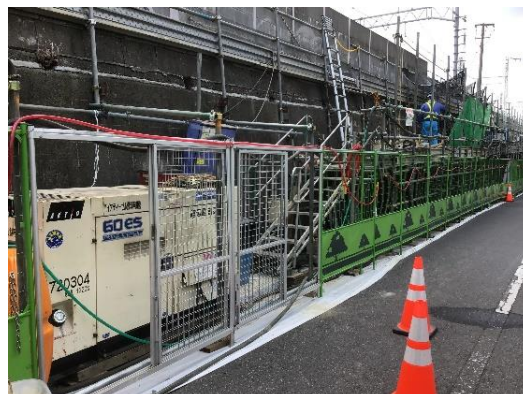
【現場設置風景】
