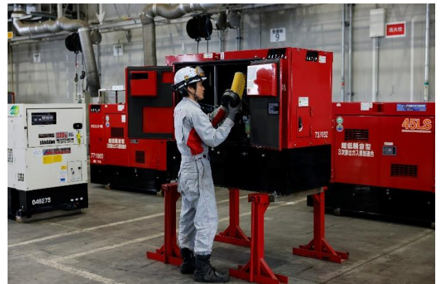
【馬台を使用し発電機の点検を行う様子】
