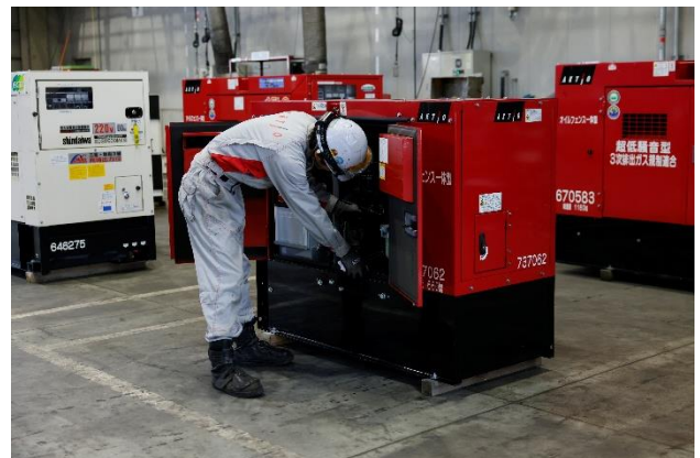
【馬台を使用せず発電機の点検を行う様子】
