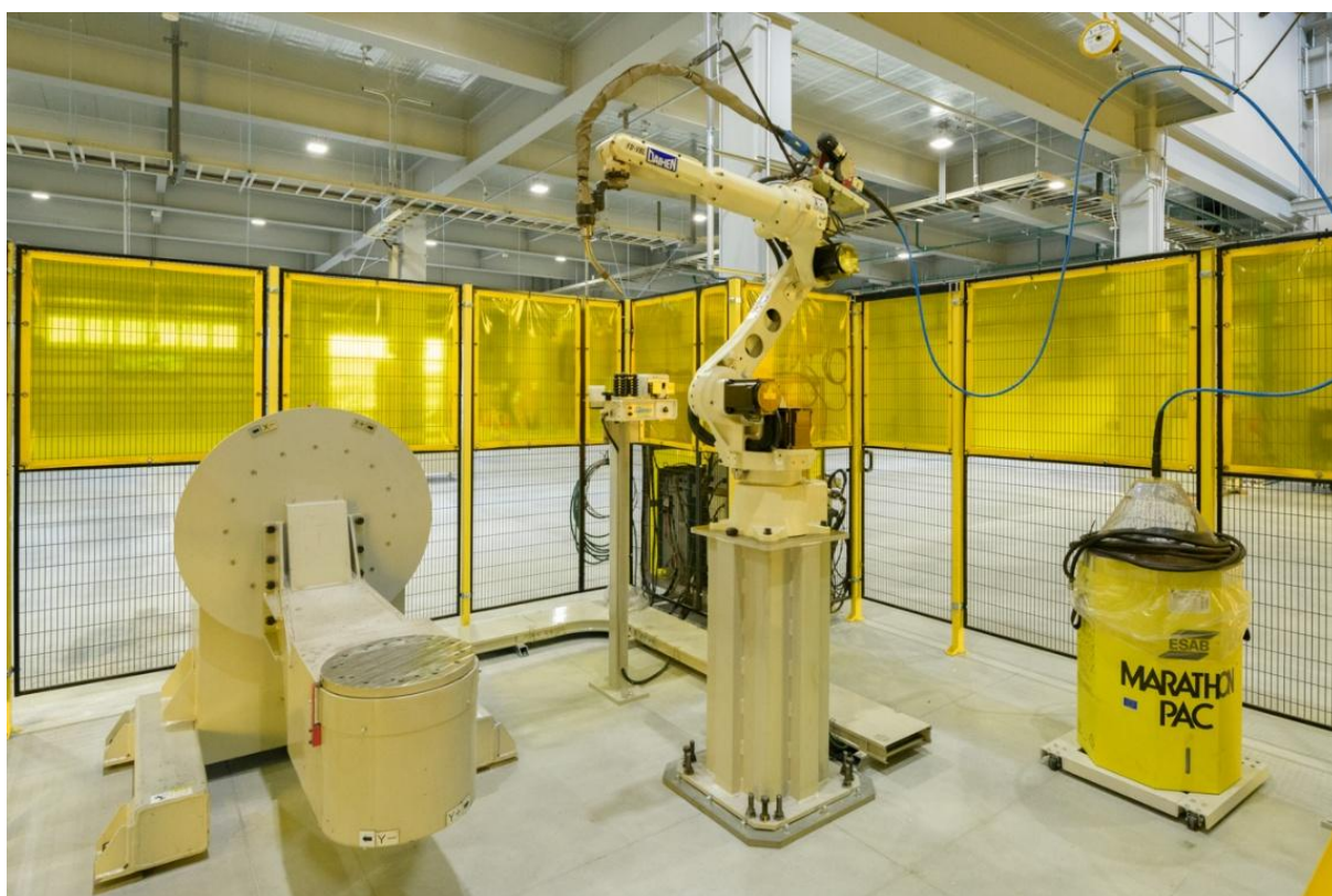
【自動溶接ロボット】
