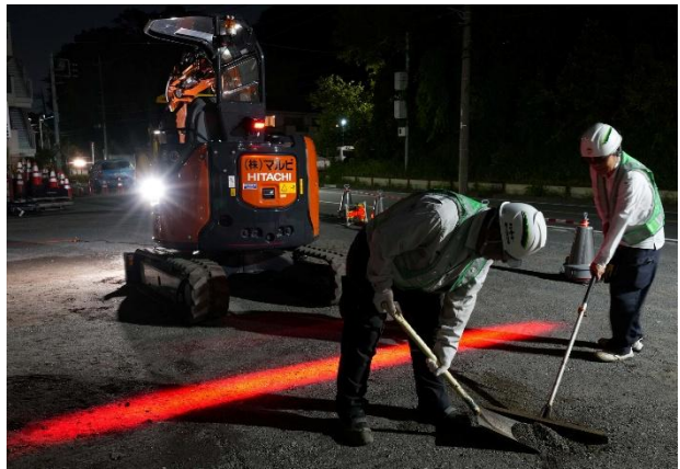
【マルビームを用いた作業風景】
