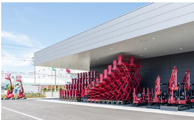
大庇下の室内系高所作業車、充電ステーションエリア
