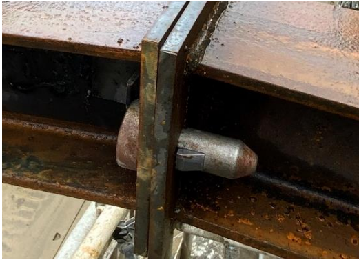
【写真3】ワンタッチ式継手ボルト
