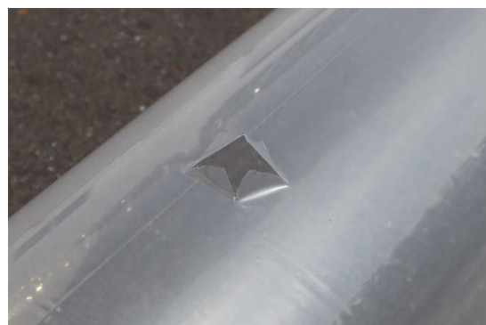
【ビニール風管ファスナー式に穴を開けた例】
