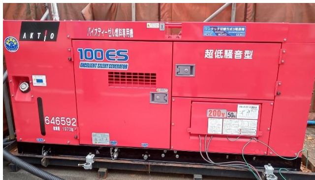
【発電容量80kVAでのB100燃料使用開始】
