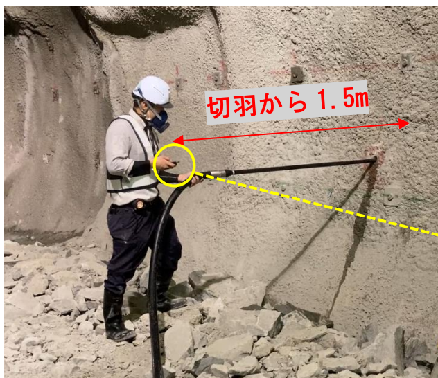
写真1 装薬作業状況
