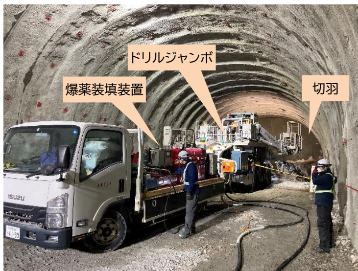
写真5 装薬時の機械配置
