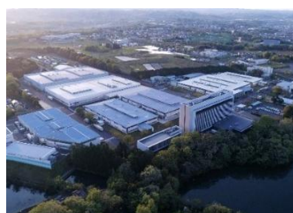
林テレンプ 本社事業所（愛知県豊田市）
