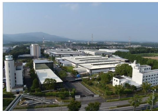
林テレンプ 本社事業所（愛知県豊田市）
