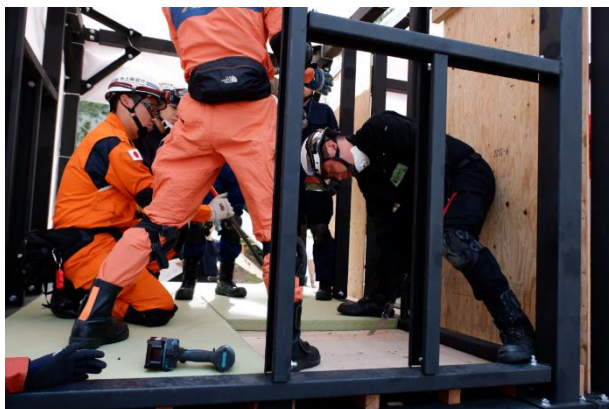
倒壊した1階へのアプローチのために2階の床材を開口
