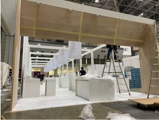
朝9時に工事を開始し、夕方には完成する展示会ブース
