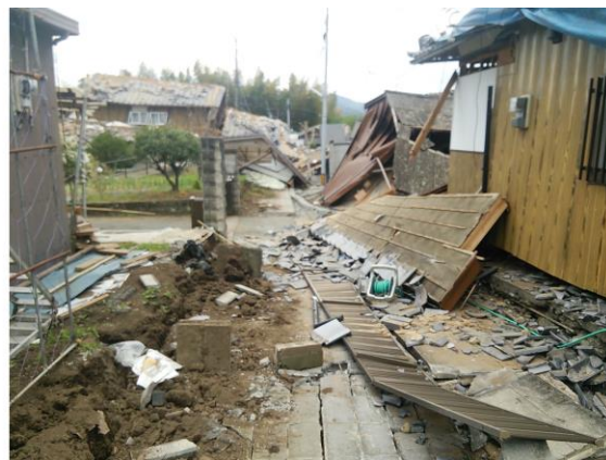
本震後に倒壊した益城町木山地区の家屋
