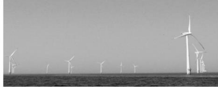
Horns Rev 1 ・大規模洋上Wind Farm第1号 ・機数 165機(10 MW) ・機高 5.7mV ・位置 沖合14~20km、水深0~14m ・事業者 丹麥エネルギー
