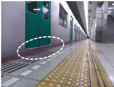
車両床面とホームとの段差低減（約2cm）
