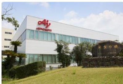
工場見学棟ホール
