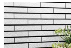
石面調の外壁タイル
