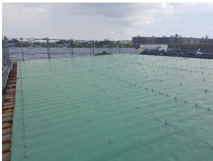
横浜市 折板屋根
