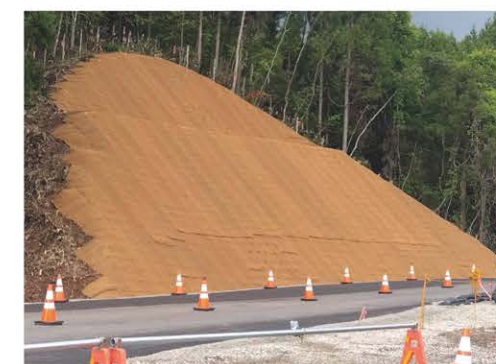
石川県穴水町
