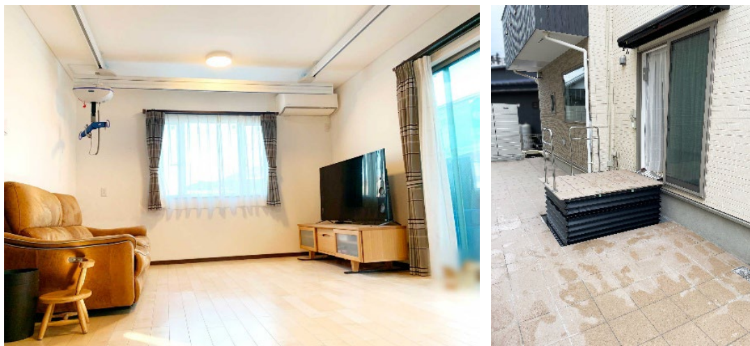
天井走行リフトの設置・向かって右の窓を玄関にして駐車場から直接リビングに入れるようにプランを提案
